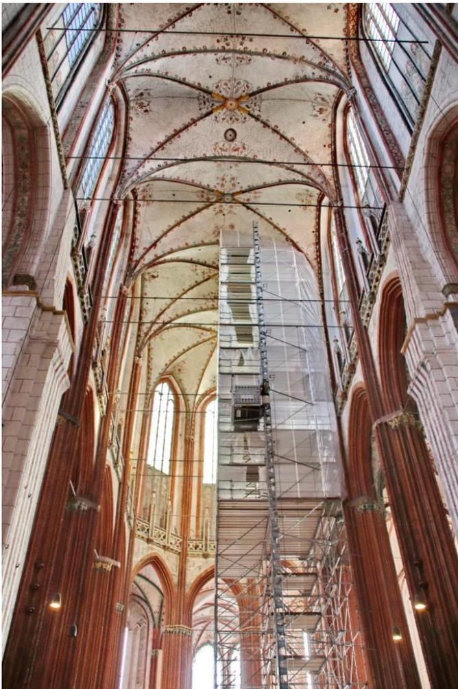
Abb. 1: Für die Musterachse eingerüsteter Bereich im Chor
